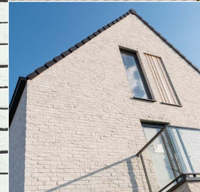
Deze handvormgevelsteen wordt vervaardigd van Limburgse Lôss, gewonnen uit het plateau van Kesselt in de Maasvallei (België) en opgewaardeerd met grondstoffen uit de Vulkaaneifel.
